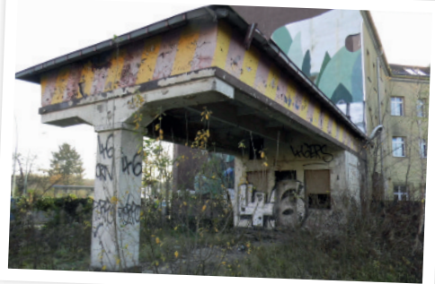
↑ Tankstelle im Dezember 2017
