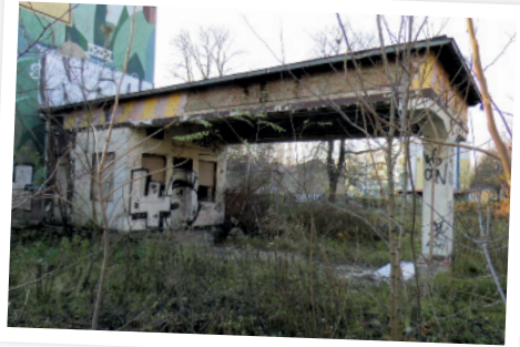
↑ Tankstelle im Dezember 2017
